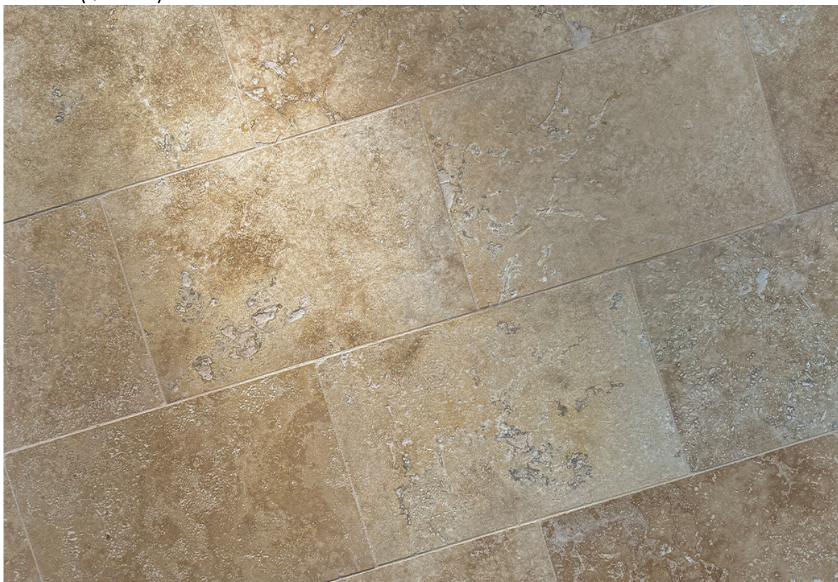
ΥΛΙΚΟ ΔΑΠΕΔΟΣΤΡΩΣΗΣ ΠΛΑΤΕΙΑΣ ΚΑΙ ΠΛΑΚΟΣΤΡΩΜΕΝΟΥ ΔΡΟΜΟΥ ΤΑΙΝΙΕΣ (ΦΙΛΕΤΑ) ΠΩΡΟΛΙΘΟΥ ΠΛΑΤΟΥΣ 20cm ΚΑΙ ΠΑΧΟΥΣ 2cm ΣΕ ΜΠΕΖ ΑΠΟΧΡΩΣΕΙΣ
