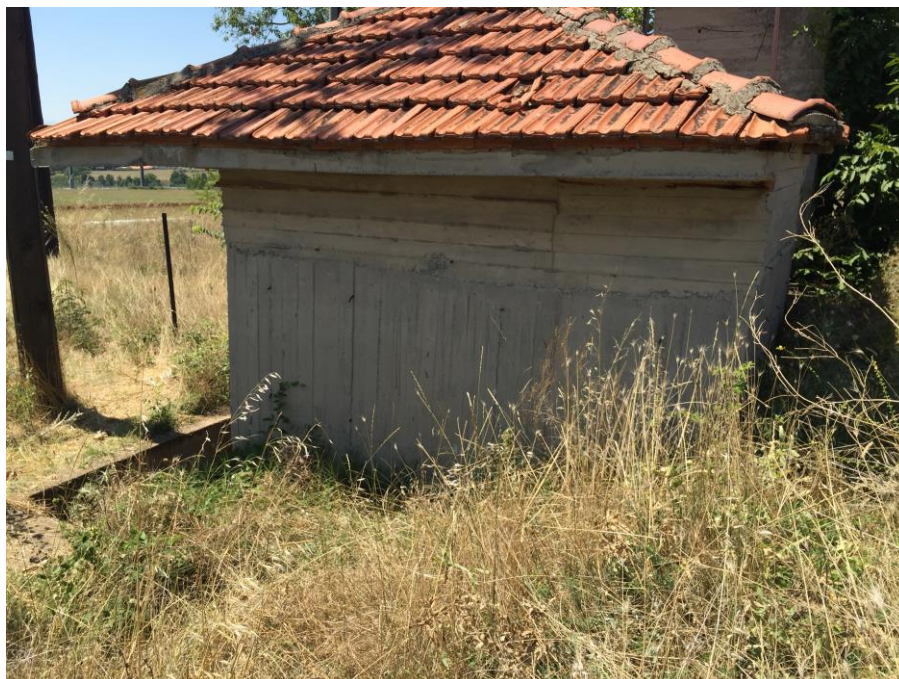
Φωτ.28: Εξωτερική κοντινή άποψη του Αντλιοστασίου Κατσέλη από τον περιβάλλοντα χώρο. Διακρίνεται ο οικίσκος Γενικού πίνακα Χαμηλής Τάσης, με φέροντα οργανισμό από οπλισμένο σκυρόδεμα
