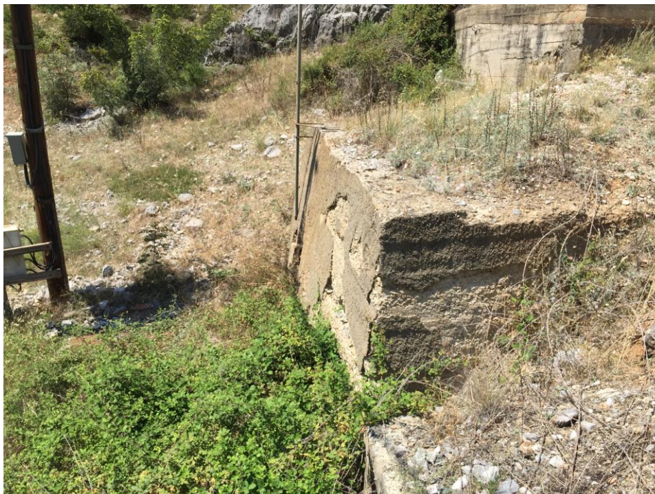
Φωτ.50: Εξωτερική άποψη και της Δεξαμενής αναρρόφησης του Αντλιοστασίου των Σφαγείων. (Λήψη από την ασφαλτοστρωμένη οδό που συνδέει την Μπάρα με τον οικισμό της Σιάτιστας. Διακρίνεται και η κολώνα της ΔΕΗ αριστερά της λήψης για τη ρευματοδότηση του Αντλιοστασίου.)
