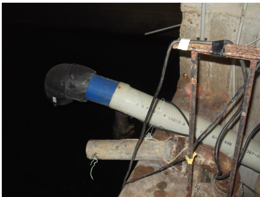
Φωτ.10: Πλησιέστερη Άποψη του υφιστάμενου καταθλιπτικού αγωγού Φ125, κλάσης 12,5atm. στην θέση εκροής του στον υγρό θάλαμο της υφιστάμενης Δεξαμενής Διακρίνονται τα ειδικά τεμάχια σύνδεσης του αγωγού με στη θέση εκροής του, καθώς και η κεκλιμένη όδευση του αγωγού PE 100 3ης γενιάς DN125mm άνωθεν του ενδιάμεσου τοιχείου της Δεξαμενής (μεταξύ βανοστασίου και υγρού θαλάμου)
