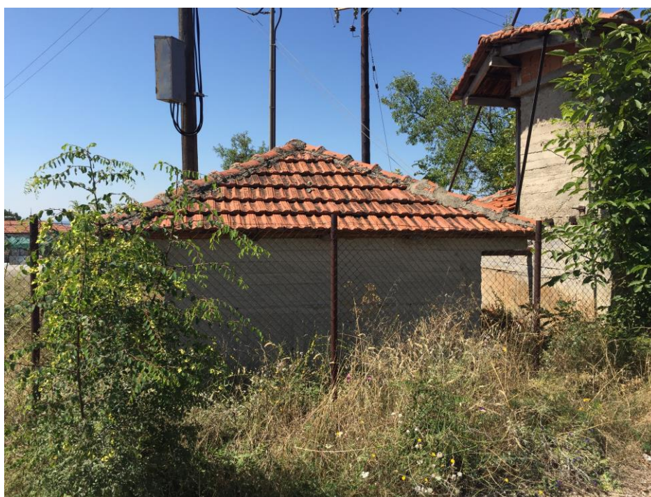
Φωτ. 18: Εξωτερική άποψη Αντλιοστασίου Κατσέλη. Λήψη από την ασφαλτοστρωμένη Δημοτική οδό πρόσβασης στο Α/Σ. Διακρίνεται αριστερά της λήψης ο οικίσκος του Γενικού Πίνακα Χαμηλής Τάσης
