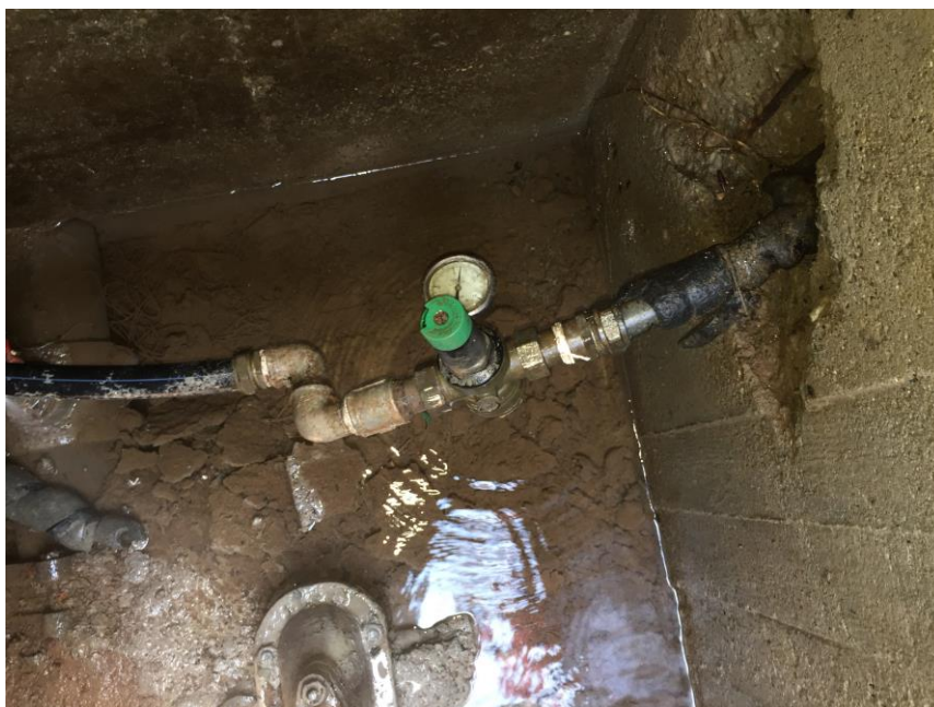
Φωτ.41 Άποψη από το εσωτερικό του υφιστάμενου φρεατίου εκκένωσης πλησίον ρέματος, κατά μήκος του υφιστάμενου πλαστικού καταθλιπτικού αγωγού Φ140μμ, κλάσης 16atm με κατεύθυνση από το Α/Σ Κατσέλη προς το Α/Σ Σφαγείων της Σιάτιστας, εξωτερικών διαστάσεων 1,60μ x 1,60m. Διακρίνεται η δικλείδα D125mm επί του αγωγού εκκένωσης, καθώς και παροχή συνδεδεμένη στο αγωγό με μειωτή πίεσης για την υδροδότηση εμπορικών δραστηριοτήτων της περιοχής (φάρμες).
