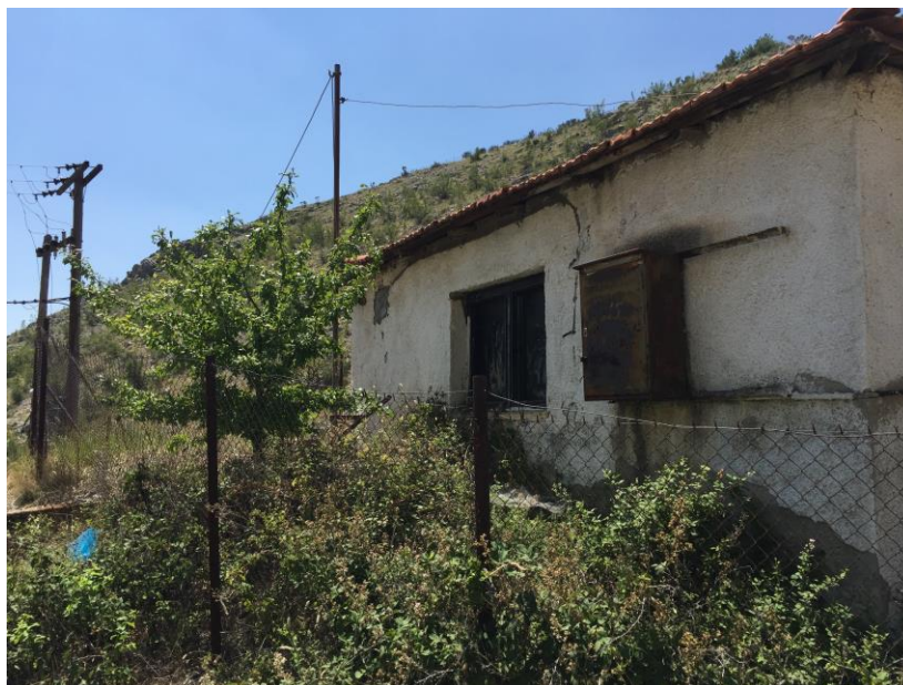
Φωτ.47: Άλλη εξωτερική άποψη του Αντλιοστασίου Σφαγείων ΝΑ του οικισμού της Σιάτιστας, σε απόλυτο υψόμετρο εδαφικού αναγλύφου της τάξης των 807,0μ όπου καταλήγει, ο υφιστάμενος αγωγός Φ140μμ, PVC, κλάσης 16α1m, μήκους 4970μ., που θα μεταφέρει το έλλειμμα υδροδότησης της Σιάτιστας (14,57l/sec) από το Α/Σ Κατσέλη (Λήψη από την ασφαλτοστρωμένη οδό που συνδέει την Μπάρα με τον οικισμό της Σιάτιστας)
