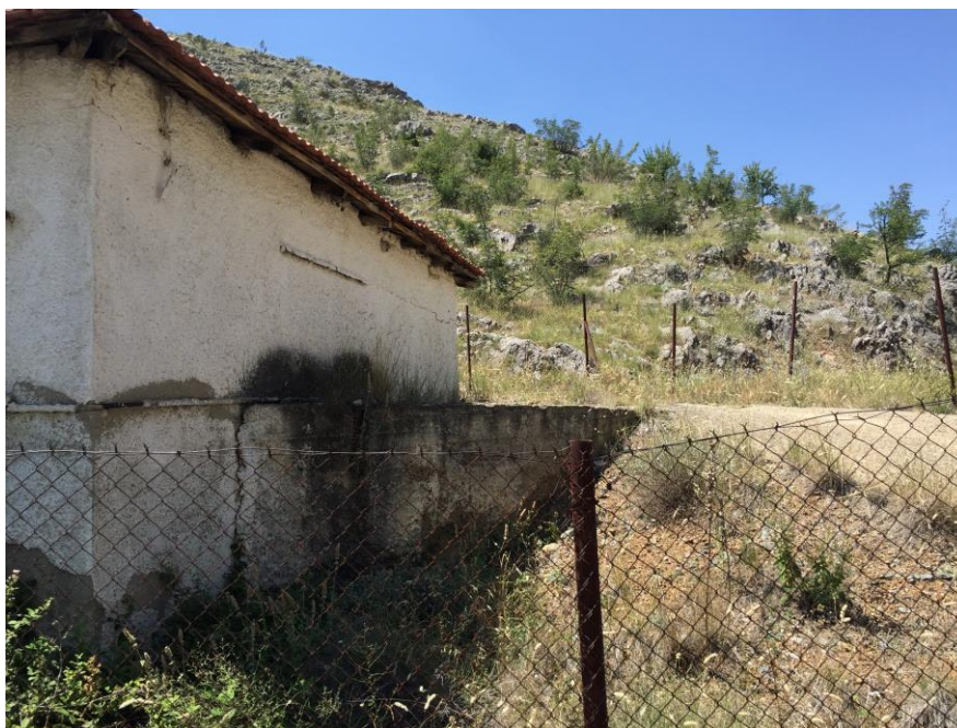
Φωτ.46: Άλλη εξωτερική άποψη του Αντλιοστασίου Σφαγείων ΝΑ του οικισμού της Σιάτιστας, σε απόλυτο υψόμετρο εδαφικού αναγλύφου της τάξης των 807,0μ όπου καταλήγει, ο υφιστάμενος αγωγός Φ140μμ, PVC, κλάσης 16α1μ, μήκους 4970μ., που θα μεταφέρει το έλλειμμα υδροδότησης της Σιάτιστας (14,57l/sec) από το Α/Σ Κατσέλη
