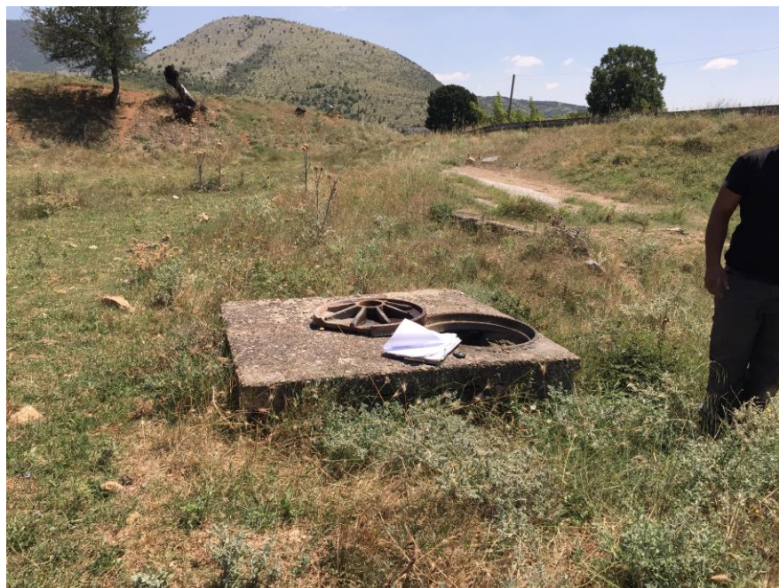
Φωτ.39: Άποψη υφιστάμενου φρεατίου εκκένωσης πλησίον ρέματος, κατά μήκος του υφιστάμενου πλαστικού καταθλιπτικού αγωγού \Phi 140\text{mm} , κλάσης 16atm με κατεύθυνση από το Α/Σ Κατσέλη προς το Α/Σ Σφαγείων της Σιάτιστας, εξωτερικών διαστάσεων 1,60m x 1,60m.. Το φρεάτιο βρίσκεται σε απόσταση περίπου 1070μ από το Α/Σ Κατσέλη. Διακρίνεται η υπερυψωμένη από το Φ.Ε. πλάκα επικάλυψης του φρεατίου και το κυκλικό καπάκι για τον έλεγχο του.
