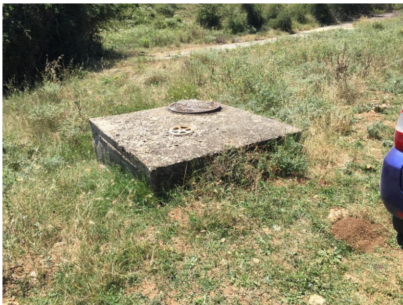
Φωτ.40 Άλλη άποψη του υφιστάμενου φρεατίου εκκένωσης πλησίον ρέματος, κατά μήκος του υφιστάμενου πλαστικού καταθλιπτικού αγωγού Φ140μμ, κλάσης 16atm με κατεύθυνση από το Α/Σ Κατσέλη προς το Α/Σ Σφαγείων της Σιάτιστας, εξωτερικών διαστάσεων 1,60μ x 1,60m.. Το φρεάτιο βρίσκεται σε απόσταση περίπου 1070μ από το Α/Σ Κατσέλη. Διακρίνεται η υπερυψωμένη από το Φ.Ε. πλάκα επικάλυψης του φρεατίου και το κυκλικό καπάκι για τον έλεγχο του.
