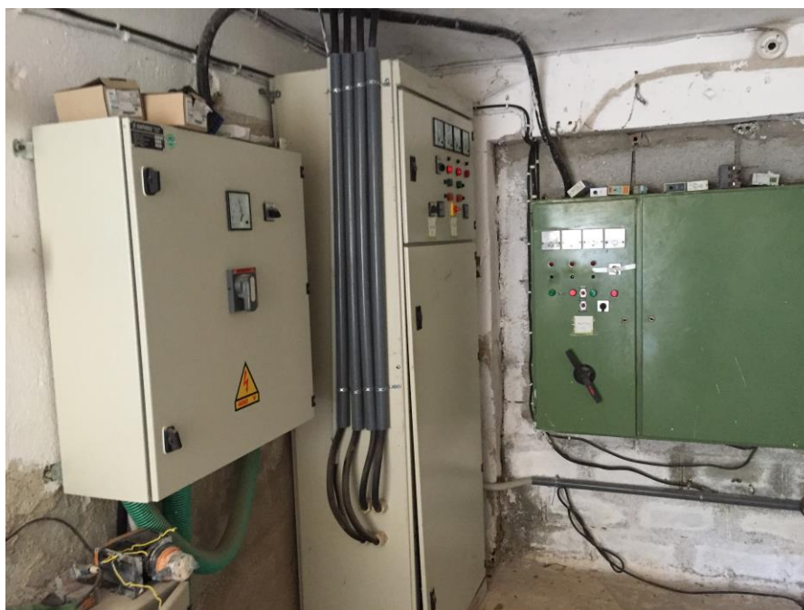
Φωτ.58: Άποψη από το εσωτερικό του αντλιοστασίου των Σφαγείων, όπου διακρίνονται ο Γενικός Πίνακας Χαμηλής Τάσης και οι Πίνακες Αυτοματισμών του Αντλιοστασίου.
