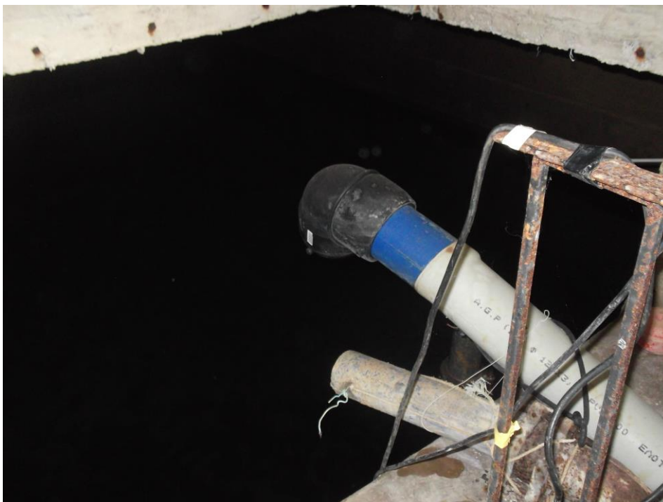
Φωτ.9: Άποψη του υφιστάμενου καταθλιπτικού αγωγού Φ125mm, κλάσης 12,5atm. στην θέση εκροής του στον υγρό θάλαμο της υφιστάμενης Δεξαμενής Διακρίνονται τα ειδικά τεμάχια σύνδεσης του αγωγού με στη θέση εκροής του (γωνία 90°).
