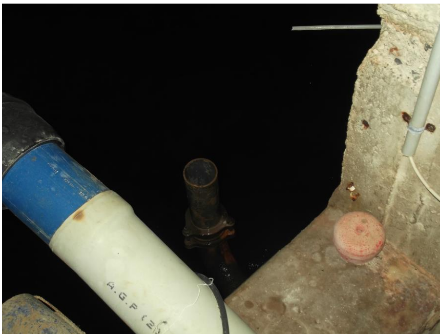
Φωτ. 11: Άλλη Πλησιέστερη Άποψη του υφιστάμενου καταθλιπτικού αγωγού Φ125, κλάσης 12,5atm. στην θέση εκροής του στον υγρό θάλαμο της υφιστάμενης Δεξαμενής. Διακρίνονται τα ειδικά τεμάχια σύνδεσης του αγωγού με στη θέση εκροής του, καθώς και η κεκλιμένη όδευση του αγωγού PE 100 3ης γενιάς DN125MM άνωθεν του ενδιάμεσου τοιχείου της Δεξαμενής (μεταξύ βανοστασίου και υγρού θαλάμου). Στο μέσον της λήψης διακρίνεται και ο μεταλλικός σωλήνας υπερχειλίσης της Δεξαμενής, που συνδέεται στο Βανοστάσιο με την εκκένωσή της Δεξαμενής, σε απόσταση 13εκ από τη στέψη του ενδιάμεσου τοιχείου.
