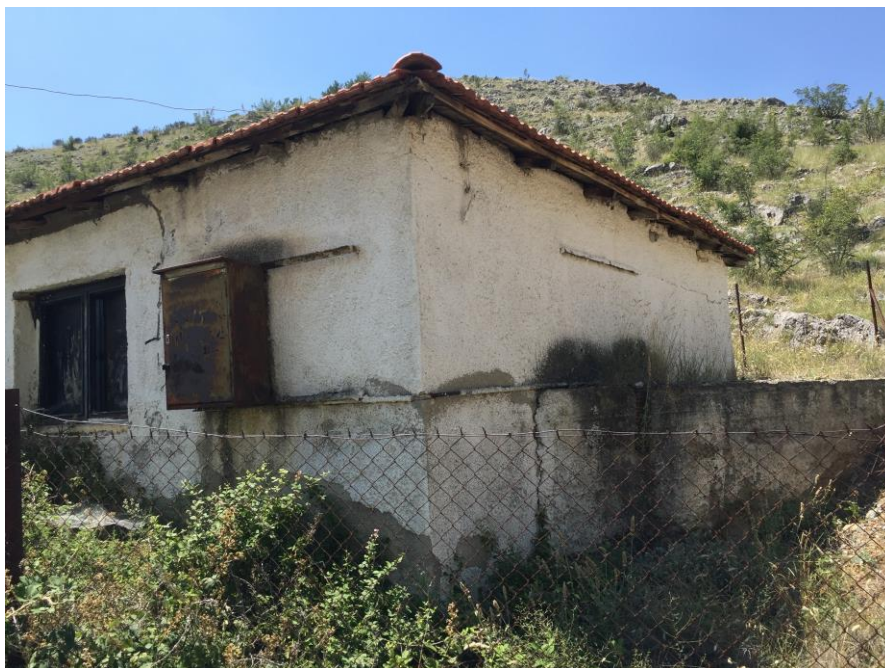
Φωτ.45: Εξωτερική Αποψη του Αντλιοστασίου Σφαγείων ΝΑ του οικισμού της Σιάτιστας, σε απόλυτο υψόμετρο εδαφικού αναγλύφου της τάξης των 807,0μ όπου καταλήγει, ο υφιστάμενος αγωγός Φ140μμ, PVC, κλάσης 16α1μ, μήκους 4970μ., που θα μεταφέρει το έλλειμμα υδροδότησης της Σιάτιστας (14,57l/sec) από το Α/Σ Κατσέλη
