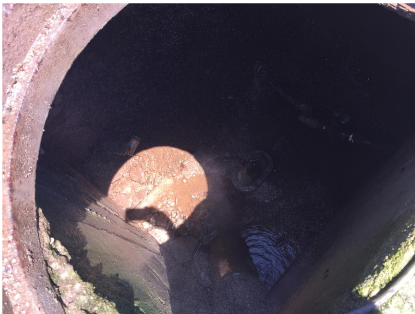
Φωτ.42 Άλλη άποψη από το εσωτερικό του υφιστάμενου φρεατίου εκκένωσης πλησίον ρέματος, κατά μήκος του υφιστάμενου πλαστικού καταθλιπτικού αγωγού Φ140μμ, κλάσης 16atm με κατεύθυνση από το Α/Σ Κατσέλη προς το Α/Σ Σφαγείων της Σιάτιστας, εξωτερικών διαστάσεων 1,60μ x 1,60m. Διακρίνεται η δικλείδα D125mm επί του αγωγού εκκένωσης καθώς και ο πλαστικός αγωγός Φ140μμ, κλάσης 16atm.
