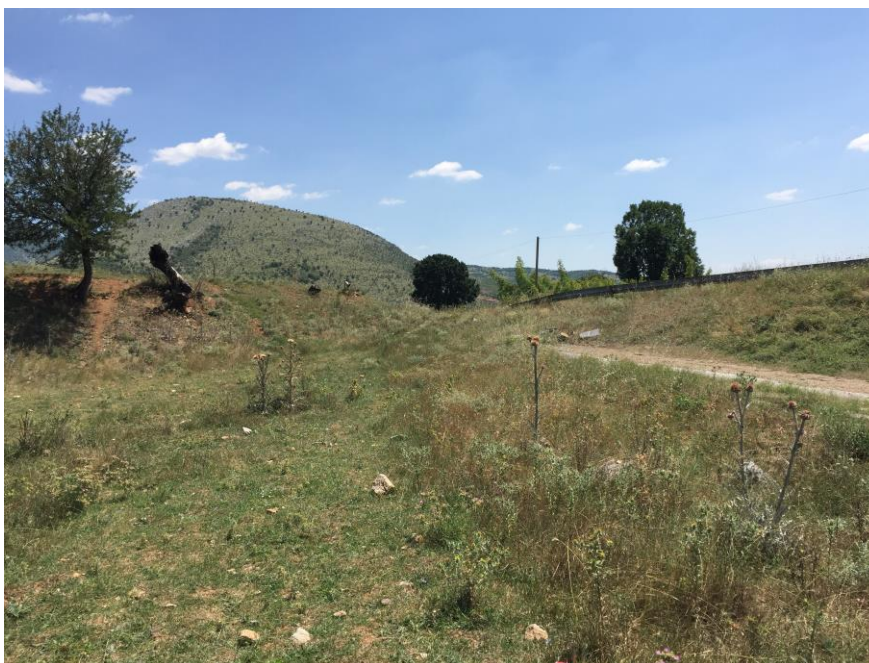
Φωτ.43 Άποψη της ευρύτερης περιοχής του υφιστάμενου φρεατίου εκκένωσης πλησίον ρέματος, κατά μήκος του υφιστάμενου πλαστικού καταθλιπτικού αγωγού Φ140μμ, κλάσης 16atm με κατεύθυνση από το Α/Σ Κατσέλη προς το Α/Σ Σφαγείων της Σιάτιστας. Το φρέατιο βρίσκεται σε απόσταση περίπου 1070μ από το Α/Σ Κατσέλη. Διακρίνεται στο βάθος της λήψης το στηθαίο ασφαλείας της Ε.Ο Κοζάνης – Ιωαννίνων.
