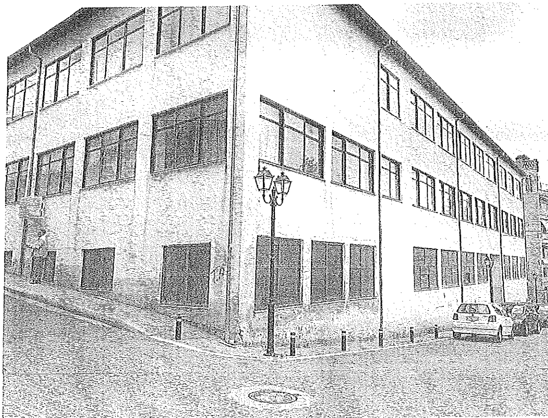
ΦΩΤ. 2: Νότια & ανατολική όψη
