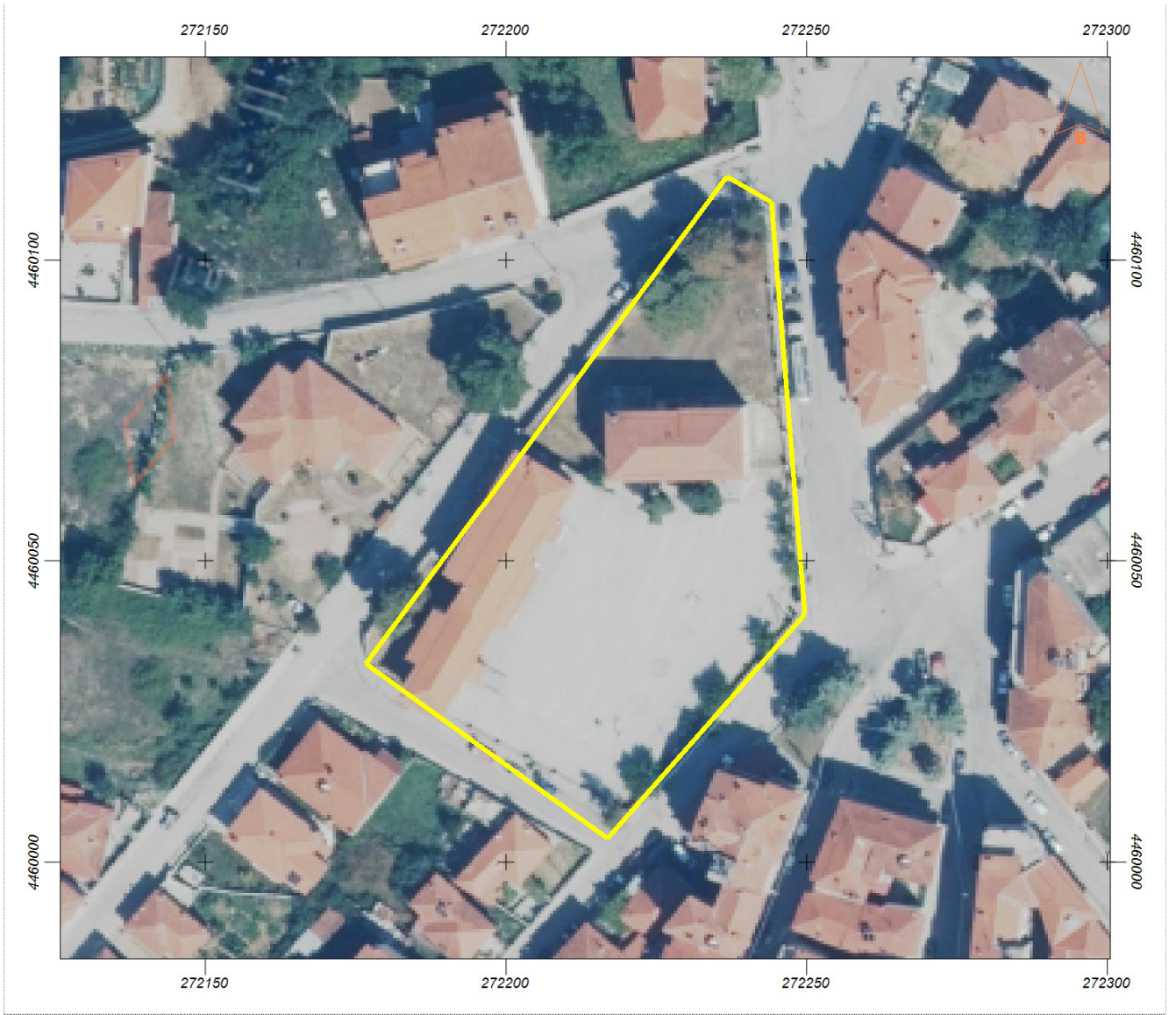
Εικόνα 1. Φωτογραφικό απόσπασμα της θέσης του Δημοτικού Σχολείου με τα δύο κτίρια.
