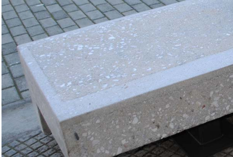
Τελικό αποτέλεσμα πελεκητής επεξεργασίας σκυροδέματος
